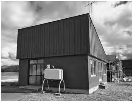
改修予定の旧教員住宅
