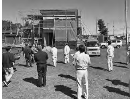
改築が進む三角点スキー場ロッジ
