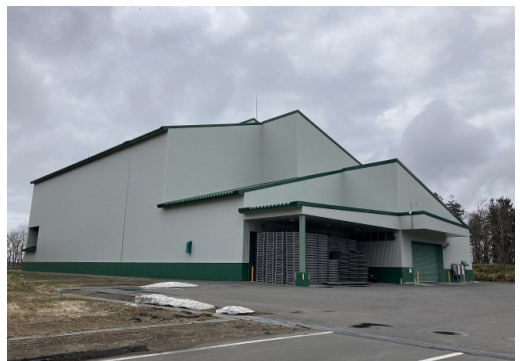
穀類乾燥調製施設
