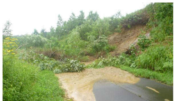
大雨により法面が崩落した昭和長島線
