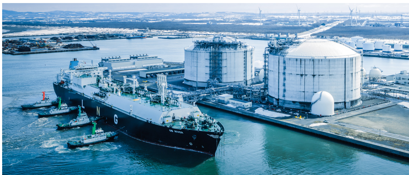
LNG基地内(LNG(液化天然ガス)を運ぶLNG船とLNGタンク)
