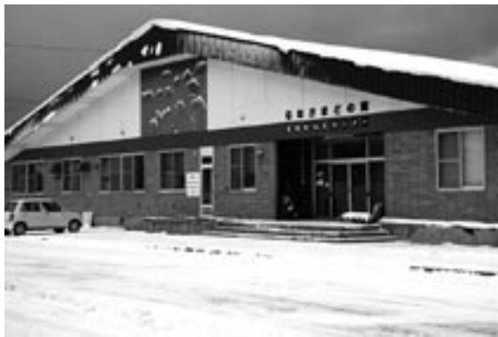
・ななかまどの館屋根改修工事
