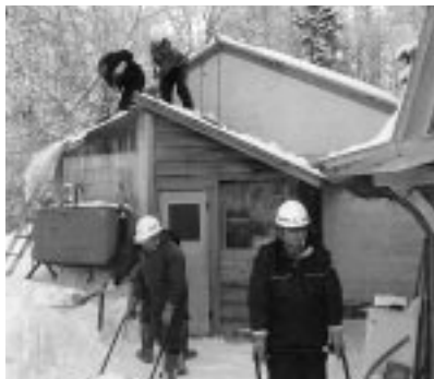
屋根などの除雪を行う東北建設(株)の職員
