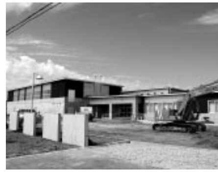
校舎が完成し外構工事が行われる苦前中学校
