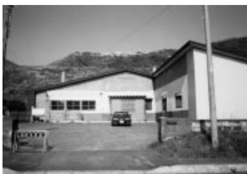
台風被害を受けた港生活改善センター
