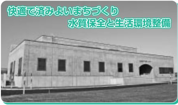
字上平に完成した苦前浄化センター
