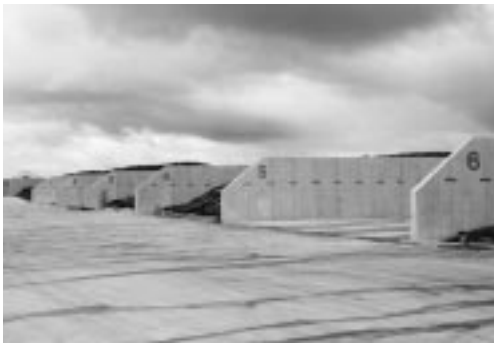
バンカーサイロ8基を備えている
