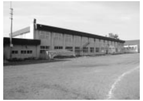
ボイラー取替えの古丹別小学校
