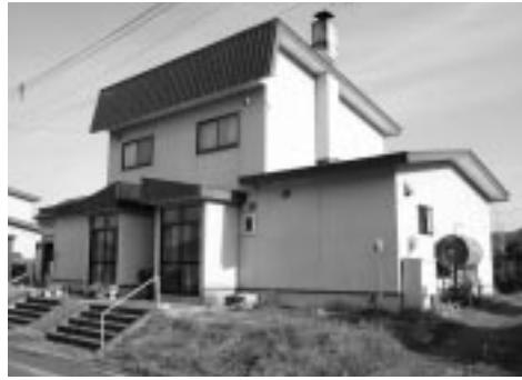
屋根取替の商工団地
