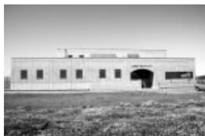
とままえ下水浄化センター
