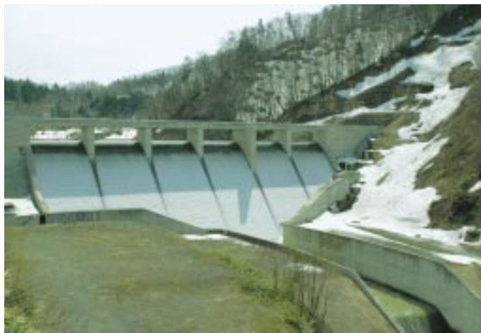
苫前ダムの越流
