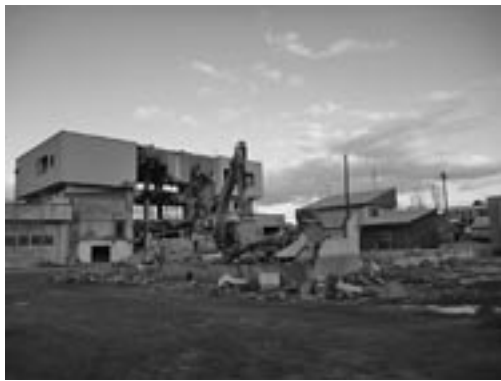
児童会館解体工事の様子
