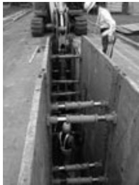
下水道工事の様子
