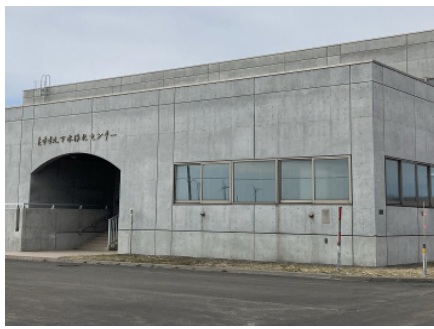
汚泥有効利用の検討が行われる下水処理場
