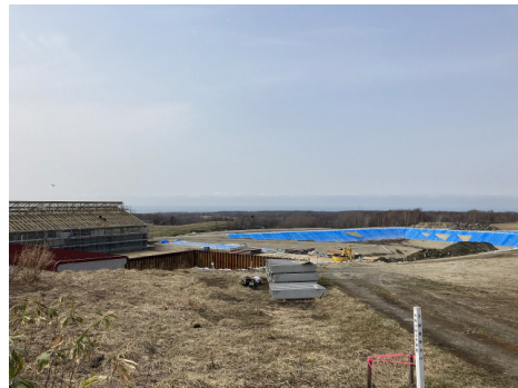
建設が進むゴミ処分場
