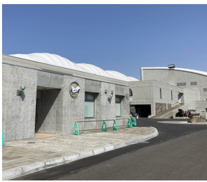
完成した道の駅物販棟
