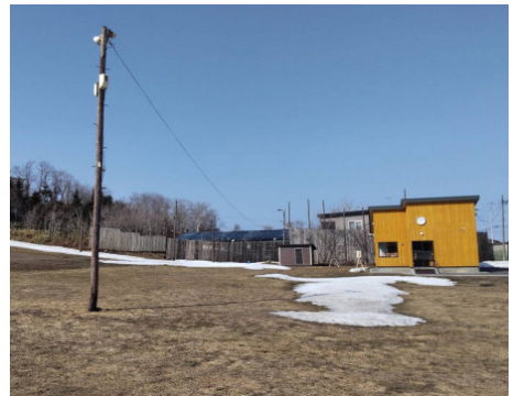
照明が更新される三角点スキー場
