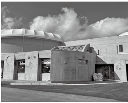
工事が進む物販棟
