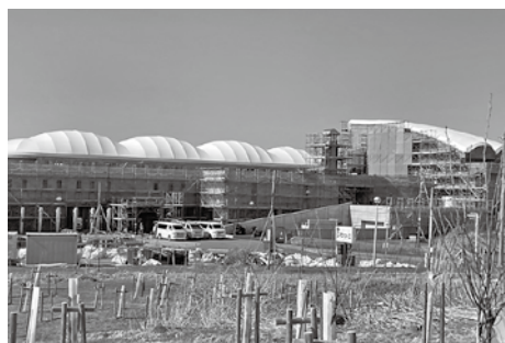
ふわっと大規模改修工事が進む
